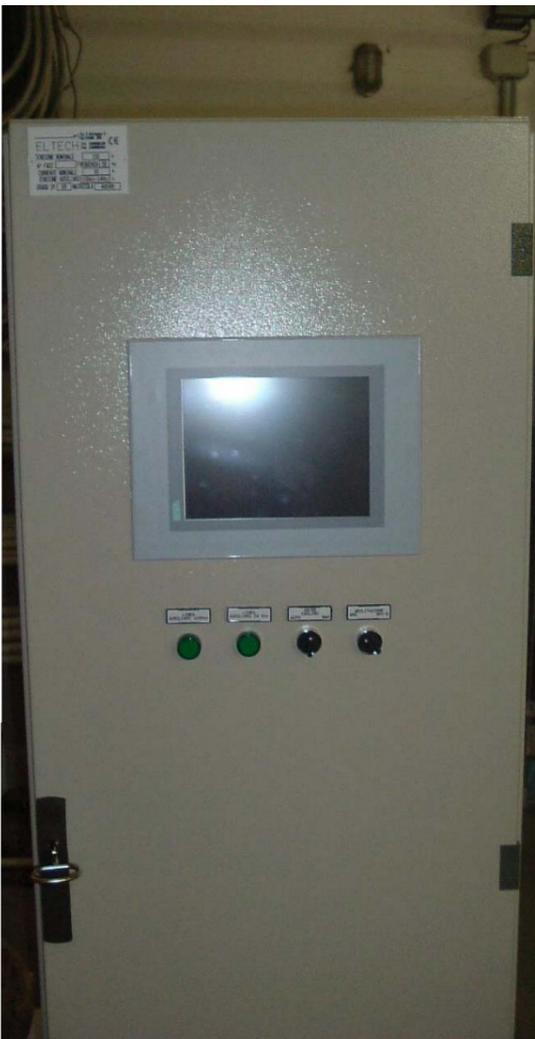
**Il lavoro è consistito nella sostituzione integrale dei quadri che alimentano i servizi ausiliari della centrale idroelettrica.**
